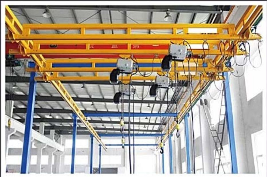
当需要有多个操作人员在同一区域同时工作时，可以采用多主梁起重机。我们通常可以采用多种形式的缓冲区域防止起重机主梁之间相互干涉。通过这种方式也可以实现用小规格的型轨承载多个主梁。比如，用500公斤承载能力的型轨可以同时承载两组500公斤承载的主梁。当然，为了防止型轨上的负载超载，我们需要采用缓冲区域保持主梁之间的间距。
